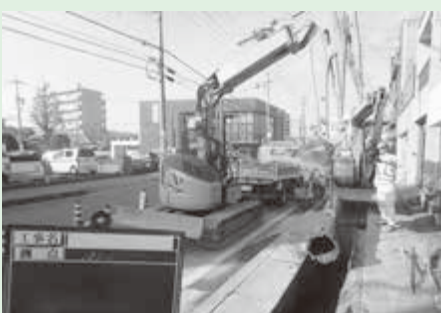
老朽した水道管を撤去する工事
